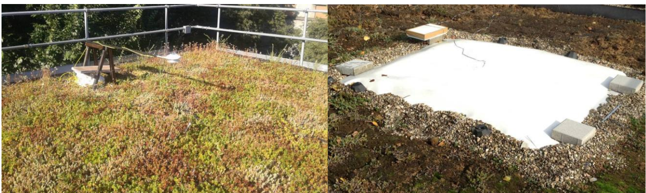
Figura 2. Copertura a verde in sedum su lapillo vulcanico, con l'albedometro posizionato sopra il campo (a sinistra); e membrana impermeabilizzante (albedo 0.77) con sonde di temperatura, sopra il terreno o sopra 6 cm di polistirene espanso estruso (a destra).
