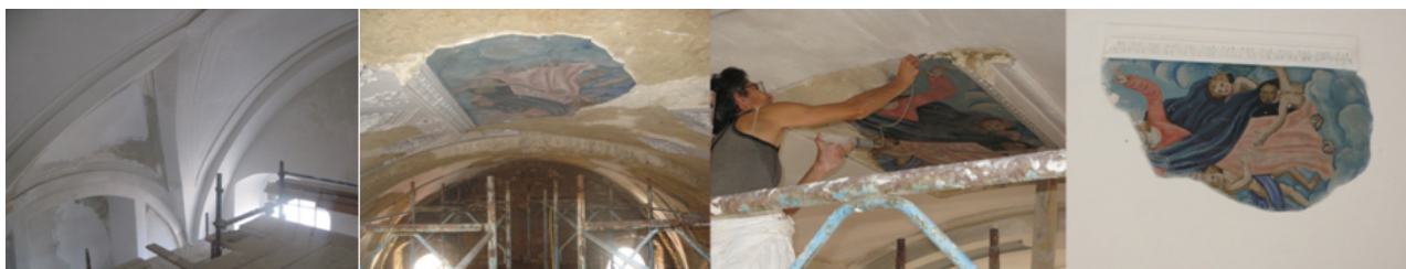
Figura 6. Chiesa di San Pietro a Forenza: fasi di ripristino dell'intonaco e consolidamento del dipinto
