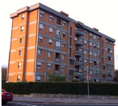
Figura 1. Vista dell'edificio (lato sud-est).
