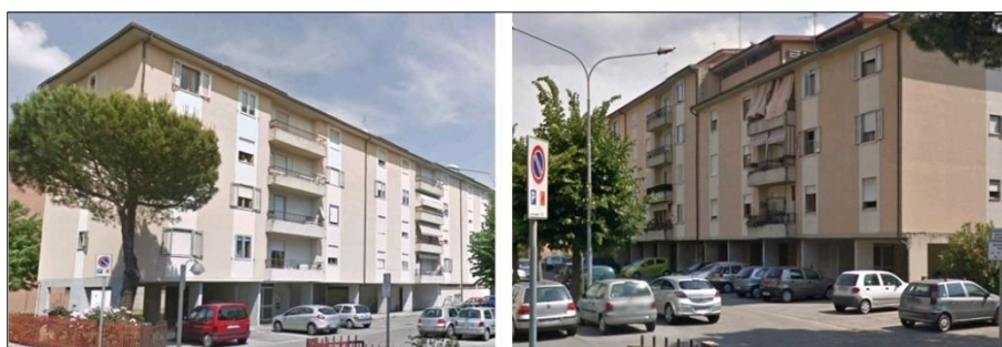
Figura 1. Edificio A (sinistra) – Edificio B (destra).
